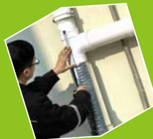
用卷尺量度安装部位的尺寸，并使用记号笔记录，注意叠缝处需多预留 3cm。
